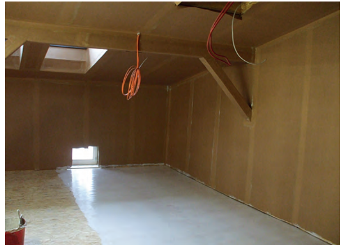
Bild 2. Verklebung der Isolierfolie Valutect
