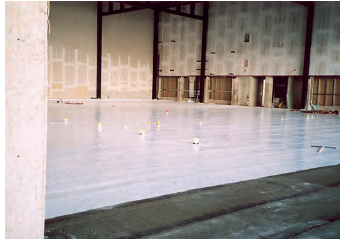
Bild 2. Gymnasium Dülmen: Sanierung mit Isolierfolie
