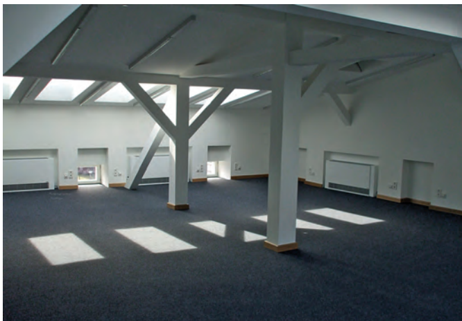
Bild 3. Seminarräume nach erfolgreicher Sanierung mit Isolierfolie Valutect (Fotos: Valutect)
