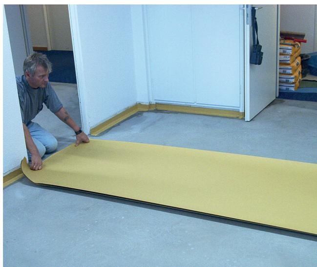
Die Sanierung von mit Schadstoffen belasteten Gebäuden mit Hilfe der Isolierfolie Valutect kann in kurzer Zeit einfach und sauber geschehen und dies sogar ohne größere Beeinträchtigung von Nutzern in anderen Teilen des Gebäudes. So können aufwändige Umzüge in Ersatzgebäude vermieden werden.
