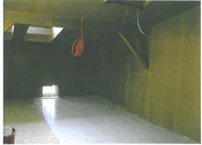
Bild 2. Verklebung der Isolierfolie Valutect
