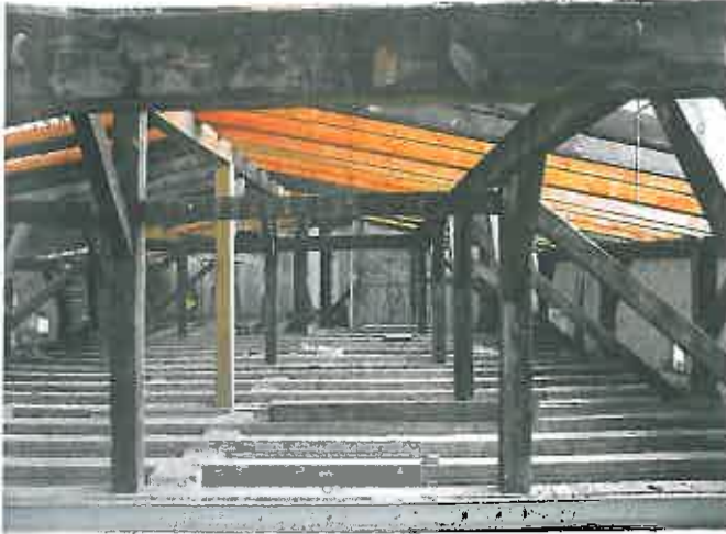
Bild 1. Der zu sanierende Dachraum nach Entfernen von Dachschalung, Bodenaufbau und Wandputz
