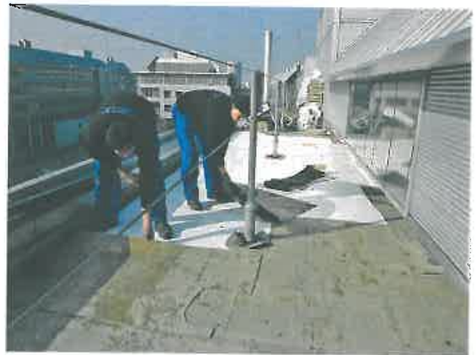
Bild 1. Die alte Abdichtung aus PVC-Dachbahnen wird in handliche Stücke zerschnitten und dem Recyclingsystem zugeführt
