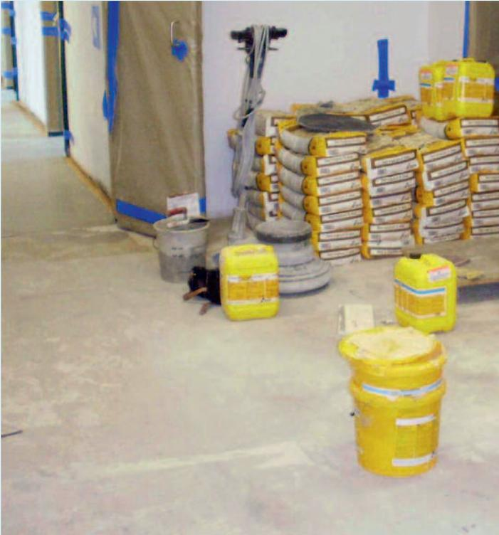
Vor den Verlegearbeiten: Erstgrundierung mit Dispersionshaftgrund, dann Auftrag der Spachtelmasse.
