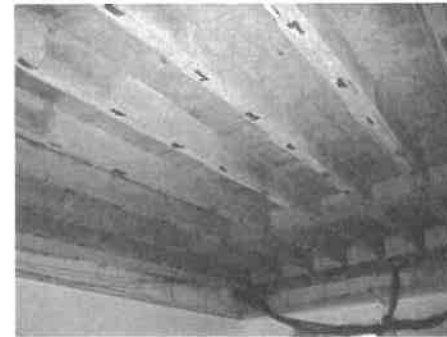
Abbildung 4: Blick auf die Unterseite der zu beklebenden Geschossdecke
