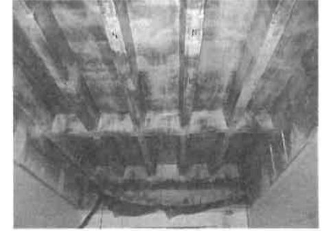
Abbildung 5: Deckenunterseite nach Auftrag des Klebers
