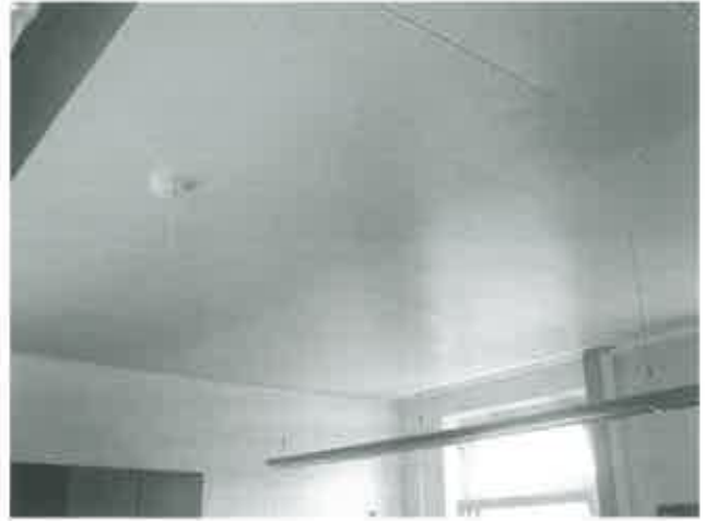
Abbildung 7: Wiederhergestellte abgehängte Decke
