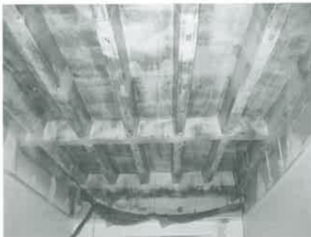
Abbildung 5: Deckenunterseite nach Auftrag des Klebers
