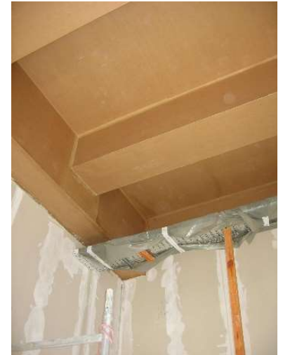
Abdichtung von Innen- und Außenecken
